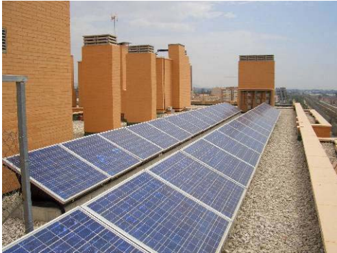
Edificio "Piso Joven" Elche (Alicante)
